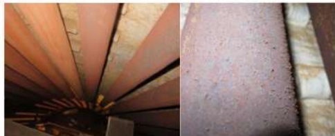
شکل ۳- رسوب تشکیل شده در تیوب بخش Radiation.
