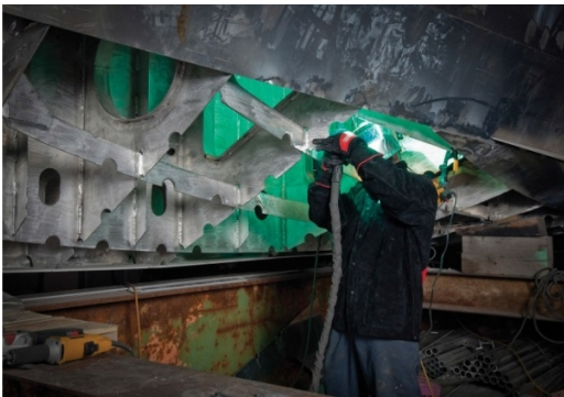
شکل 1 - یک جوشکار روی بدنه قایق آلومینیومی کار می‌کند.
