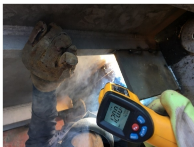
شکل 2- انجام کنترل دمای پیش گرم و بین پاسی طبق دستورالعمل توسط ترمومتر لیزری.
